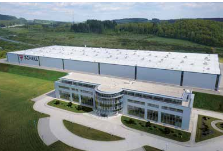
Werk 1 Produktion mit Verwaltungsgebäude und Schulungszentrum
