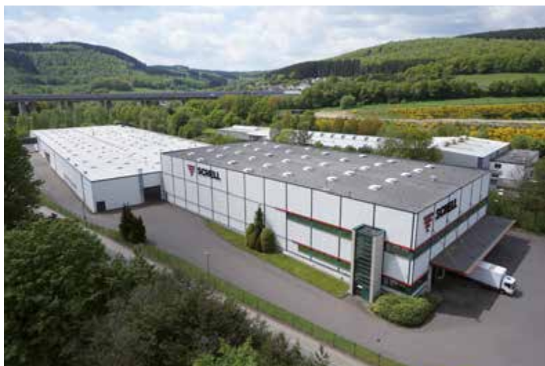
Werk 2 Produktion mit Logistikzentrum
