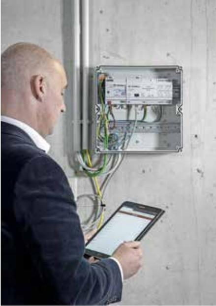
Mit dem Wassermanagement-System „SWS“ können Schell-Armaturen und Wartungseinätze zentral gesteuert werden. Dazu gehört auch die Dokumentation aller Wasserwechsel und Betriebstemperaturen sowie Informationen für eine vereinfachte Instandhaltung.
