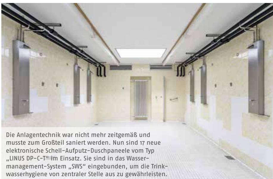
Die Anlagentechnik war nicht mehr zeitgemäß und musste zum Großteil saniert werden. Nun sind 17 neue elektronische Schell-Aufputz-Duschpaneele vom Typ „LINUS DP-C-T“ im Einsatz. Sie sind in das Wassermanagement-System „SWS“ eingebunden, um die Trinkwasserhygiene von zentraler Stelle aus zu gewährleisten.
