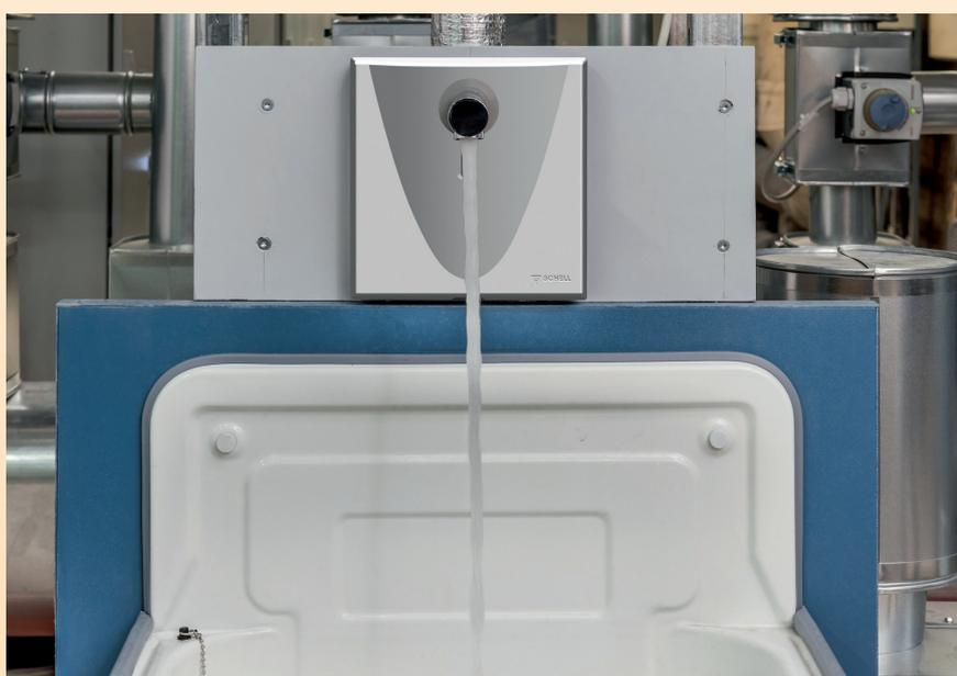
Das Ausgussbecken in der Lüftungszentrale mit der elektronischen Kaltwasser-Aufputzarmatur ‚Walis‘: Durch die Temperaturerfassung am Server wird bei Überschreitung kritischer Kaltwassertemperaturen eine Hygienespülung aktiviert.
