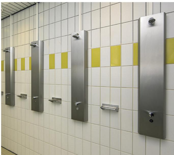
Die Edelstahl-Duschpaneele „Linus Inox DP-C-T“ von Schell sorgen im Westbad Ulm durch die Touch-Bedienung mit selbstschließender Funktion für einen hohen Hygienekomfort. Zudem ermöglichen sie automatische Stagnationsspülungen und tragen so auch zum Erhalt der Trinkwassergüte bei.
