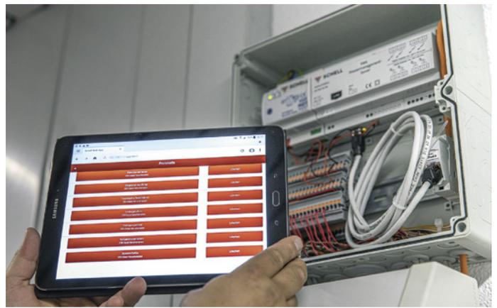
Mit dem Schell Wassermanagement-System „SWS“ können die in einem Gebäude befindlichen elektronischen Schell-Armaturen vernetzt und bequem programmiert werden. Im Westbad Ulm wird dies unter anderem genutzt, um beispielsweise die Stagnationsspülungen automatisch an allen 18 Duschpaneelen gleichzeitig auszulösen.
