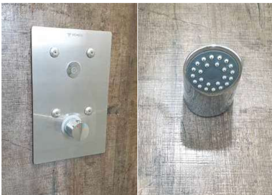
Wie alle anderen Armaturen der Sanitäranlage und Küche sind auch die Unterputz-Duschen „Linus Basic“ mit dem Schell Wassermanagement-System „SWS“ verbunden.
