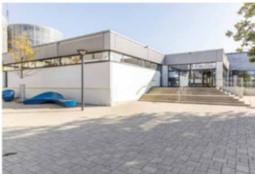
Bei der Renovierung des Westbades Ulm galt ein besonderes Augenmerk dem Erhalt der Trinkwasserhygiene und dem wirtschaftlichen Betrieb.
