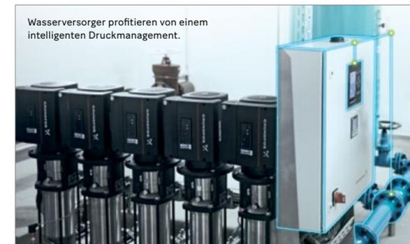
Zudem werden die Energie-, Betriebs- und Wartungskosten reduziert, was eine enorme finanzielle Einsparung ermöglicht. Nach den Erfahrungen von Grundfos aus rund 100 Druckmanagement-Projekten ergeben sich im Durchschnitt 15 Prozent geringere Leckagen, 25 Prozent Energieeinsparungen und 35 Prozent weniger Rohrbrüche.
