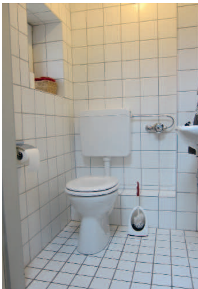
Typisches WC im unteren und mittleren Wohnungsbau. Auch hier ist eine Umrüstung auf ein WC mit Hygieneschale problemlos möglich.
