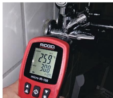
Bild 5: Mittels IR-Thermometer lässt sich vor Ort überprüfen, ob grundsätzliche mikrobiologische Risiken drohen. Im Beispiel kam es zu einer Überströmung von Warmwasser ins Kaltwasser, weil beim Eckventilthermostat der Rückflussverhinderer defekt war. Das Eckreguliventil war ohne Armaturennutzung ungewöhnlich warm, obwohl die Zirkulationsleitung ca. 90 cm entfernt war.
