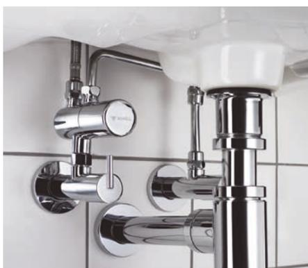
Bild 3: Sind an Eckventilen oder in Waschtisch-Armaturen Thermostate installiert, so muss die Ermittlung der Systemtemperatur im Rahmen von Legionellenuntersuchungen unbedingt vor den thermostatischen Einrichtungen erfolgen.
