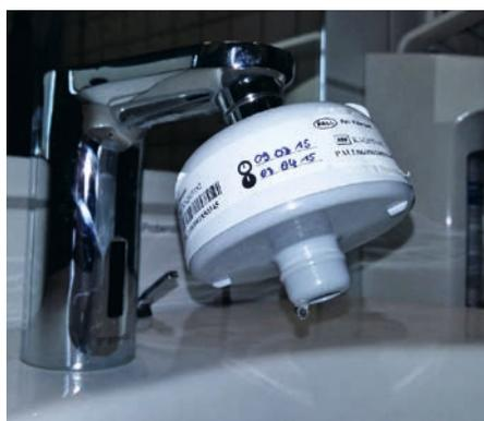
Bild 4: Zur unmittelbaren Gefahrenabwehr bei hohen mikrobiologischen Kontaminationen können auch im außermedizinischen Bereich temporär Sterilfilter eingesetzt werden, soweit sich der Filterabgang mindestens 20 mm über der Keramik befindet. Sanitärarmaturen mit bedarfsabhängiger Stagnationsspülung unterstützen den bestimmungsgemäßen Betrieb (im Bild: Waschtisch-Armatur Celis E).
