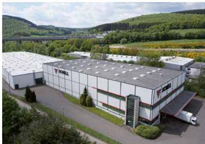
Usine 2 – Production et centre logistique
