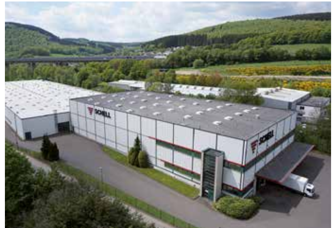
Werk 2 Produktion mit Logistikzentrum
