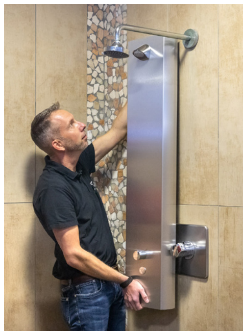
Staré přípojky jsou po montáži jednoduše zakryté sprchovými panely LINUS.
