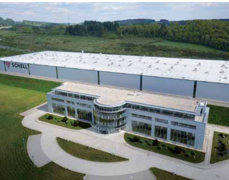
Usine 1 Production, locaux administratifs et centre de formation
