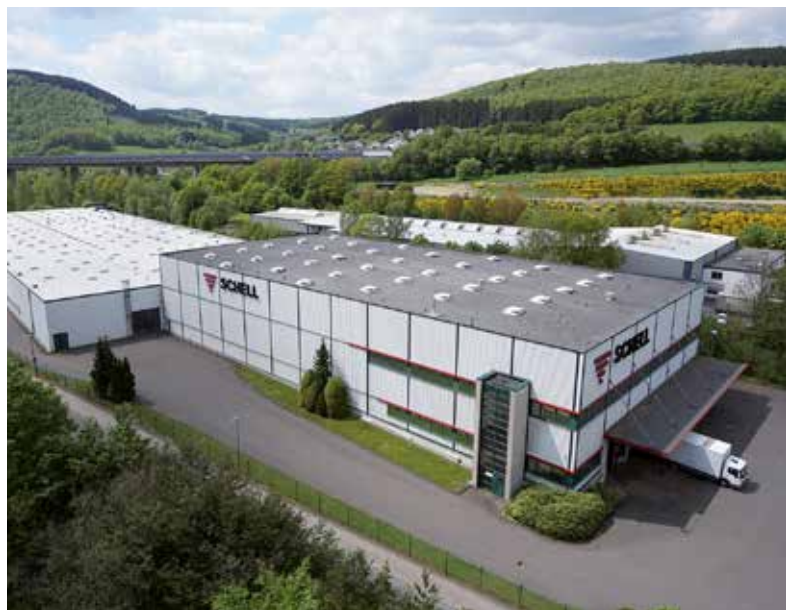
Usine 2 Production et centre logistique
