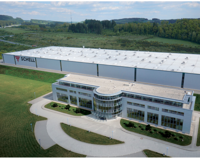
Werk 1 Produktion mit Verwaltungsgebäude und Schulungszentrum
