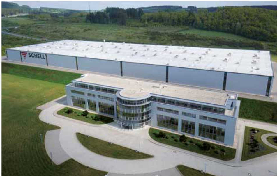
Fabriek 1 - Productie met administratiegebouw en opleidingscentrum
