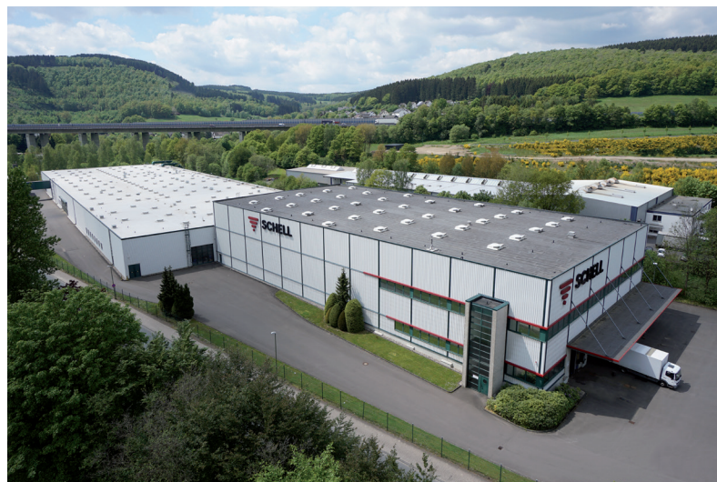
Usine 2 Production et centre logistique
