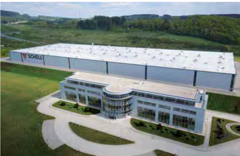
Werk 1 Produktion mit Verwaltungsgebäude und Schulungszentrum
