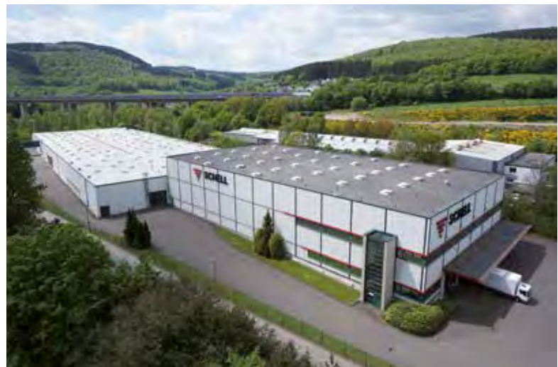
Werk 2 Produktion mit Logistikzentrum
