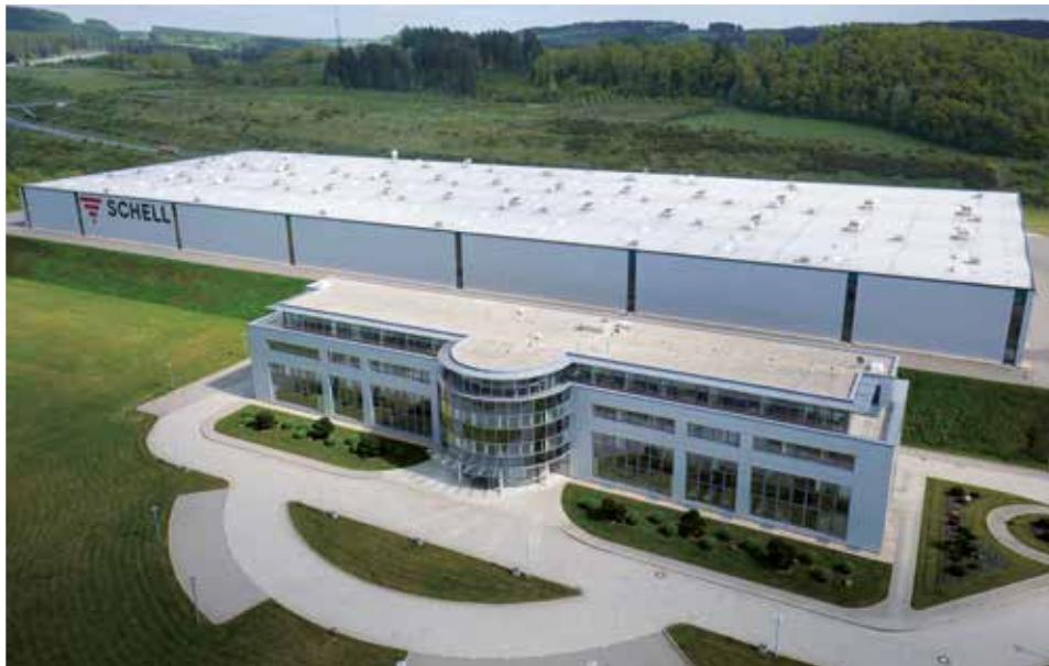
Usine 1 – Production avec bâtiment administratif et centre de formation
