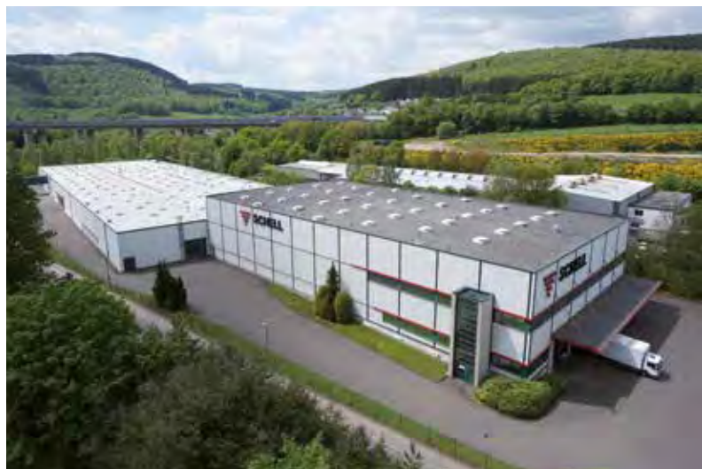
Usine 2 Production et centre logistique
