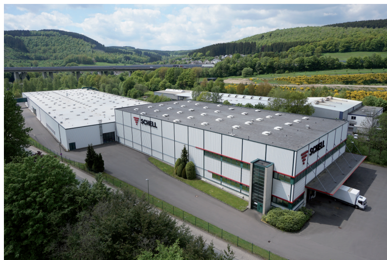
Usine 2 Production et centre logistique
