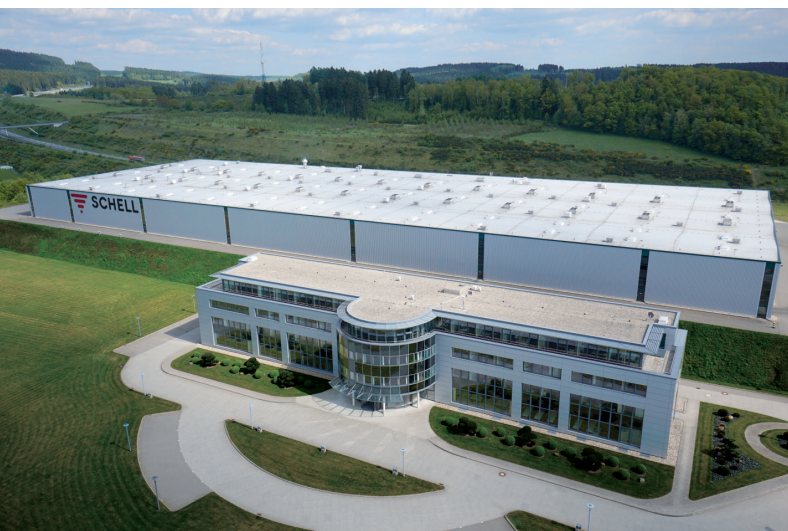
Usine 1 Production, bâtiment administratif et centre de formation
