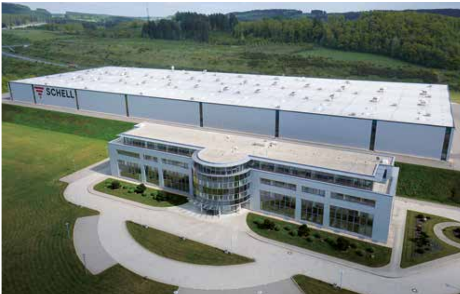
Werk 1 – Produktion mit Verwaltungsgebäude und Schulungszentrum
