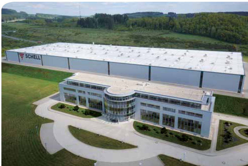
Fabriek 1 - Productie met administratiegebouw en opleidingscentrum
