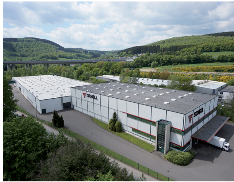
Gebouw 2 Productie met logistiek centrum
