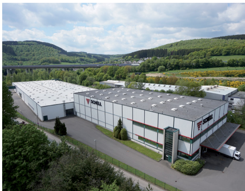
Usine 2 Production et centre logistique
